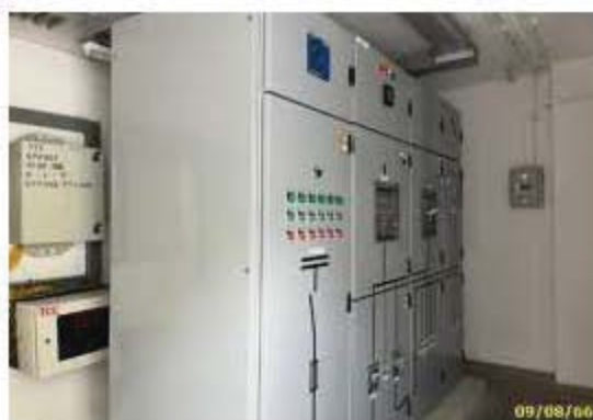
หม้อแปลงไฟฟ้า ขนาด 800 KVA พร้อมตู้ควบคุมไฟฟ้าอาคาร C
