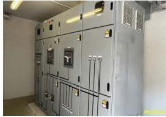
หม้อแปลงไฟฟ้า ขนาด 800 KVA พร้อมตู้ควบคุมไฟฟ้าอาคาร E
