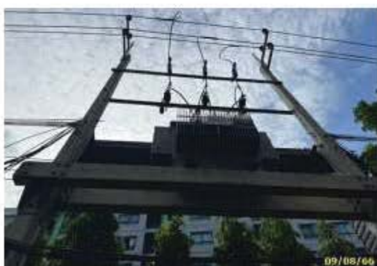
หม้อแปลงไฟฟ้า ขนาด 800 KVA พร้อมตู้ควบคุมไฟฟ้าอาคาร B
