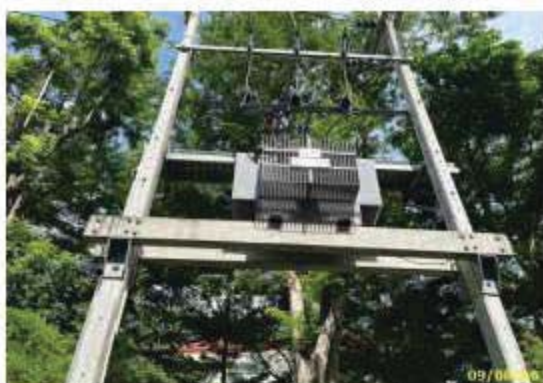
หม้อแปลงไฟฟ้า ขนาด 800 KVA พร้อมตู้ควบคุมไฟฟ้าอาคาร C
