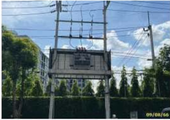
หม้อแปลงไฟฟ้า ขนาด 800 KVA พร้อมตู้ควบคุมไฟฟ้าอาคาร E
