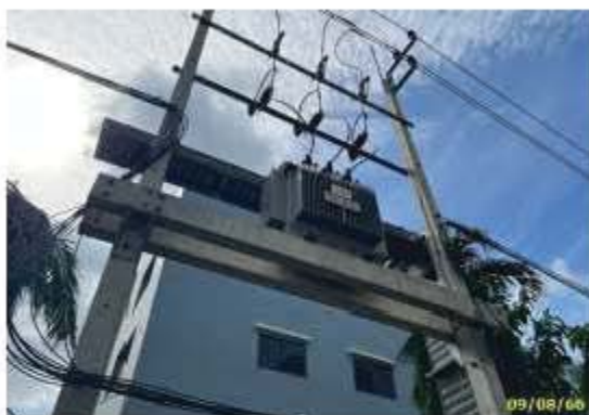
หม้อแปลงไฟฟ้า ขนาด 630 KVA พร้อมตู้ควบคุมไฟฟ้าอาคาร A
